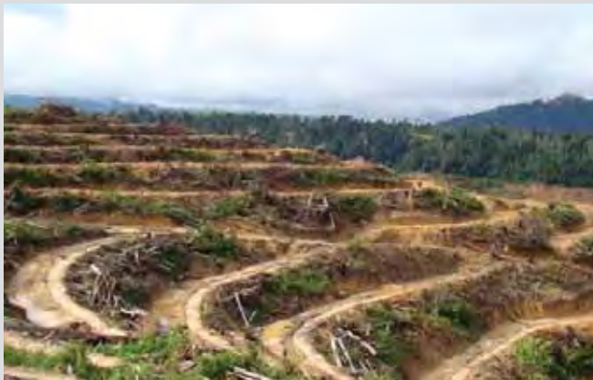
Kerja-kerja pembangunan yang agresif sedang dijalankan di Estet Millian Labau, Sabah.
