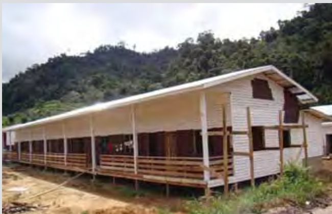
Pembinaan rumah-rumah baru untuk kediaman pekerja di Estet Millian Labau, Sabah.
